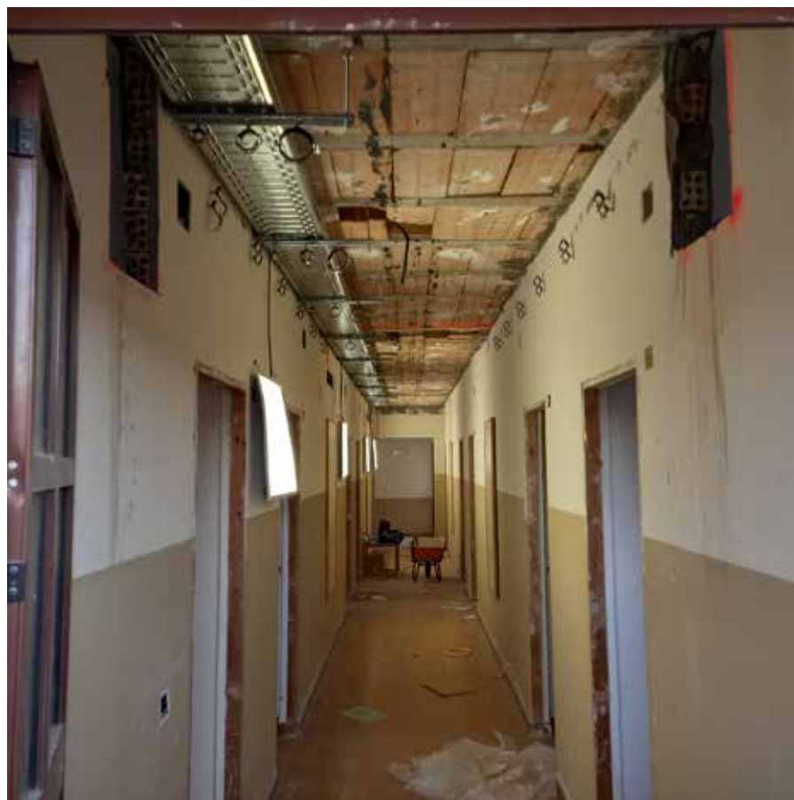
Trabajos de acondicionamiento sede futuro H. psiquiátrico penitenciario Alcalá de Guadaira
