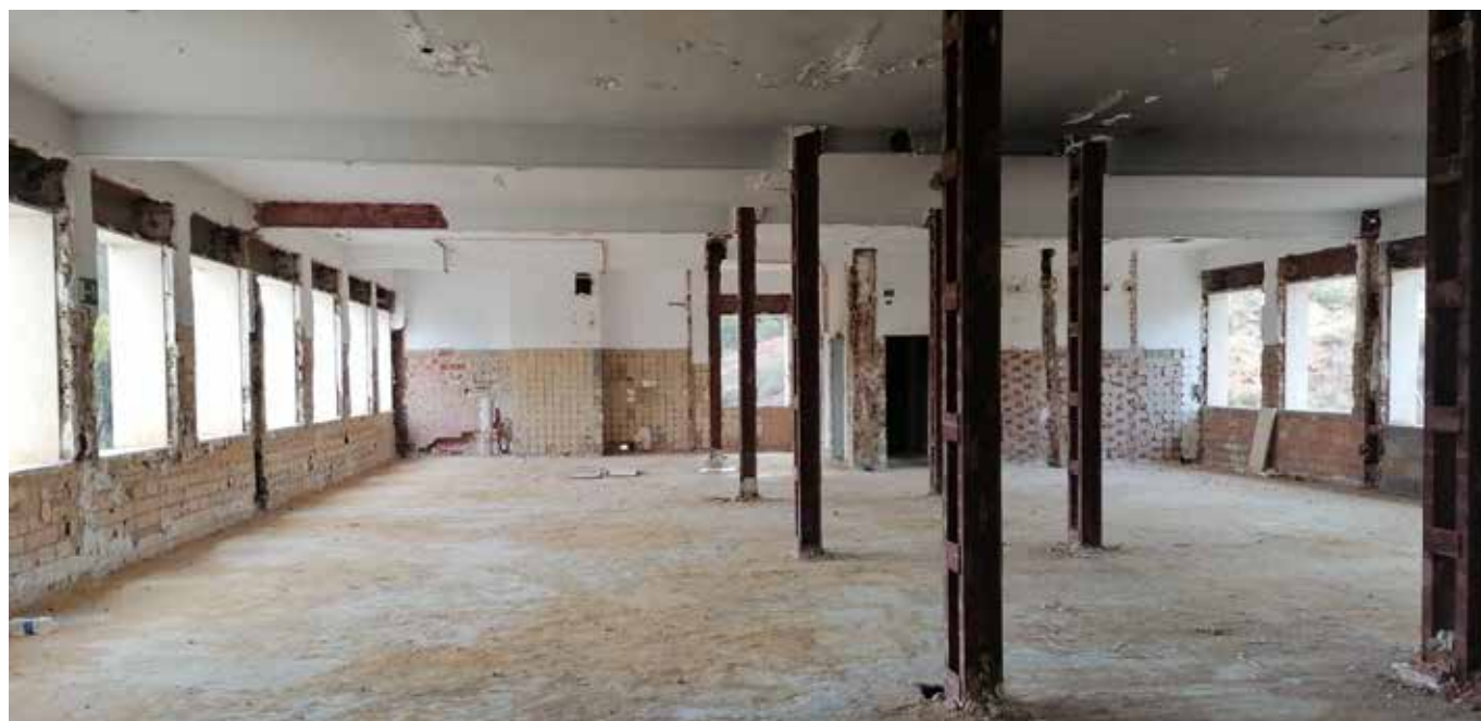
Trabajos de demolición interior sede futuro Centro de Estudios Penitenciarios Cuenca
