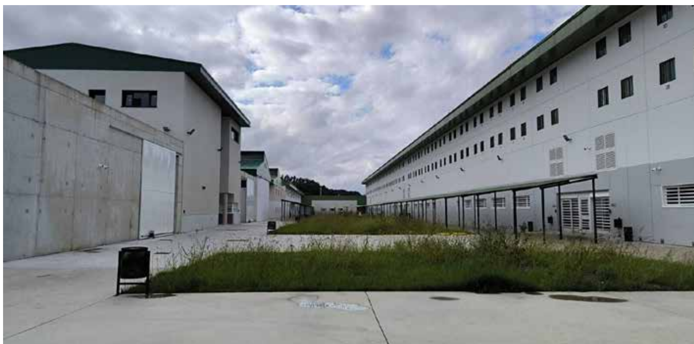
Calle de módulos residenciales CP Norte III, Donostia, San Sebastián
