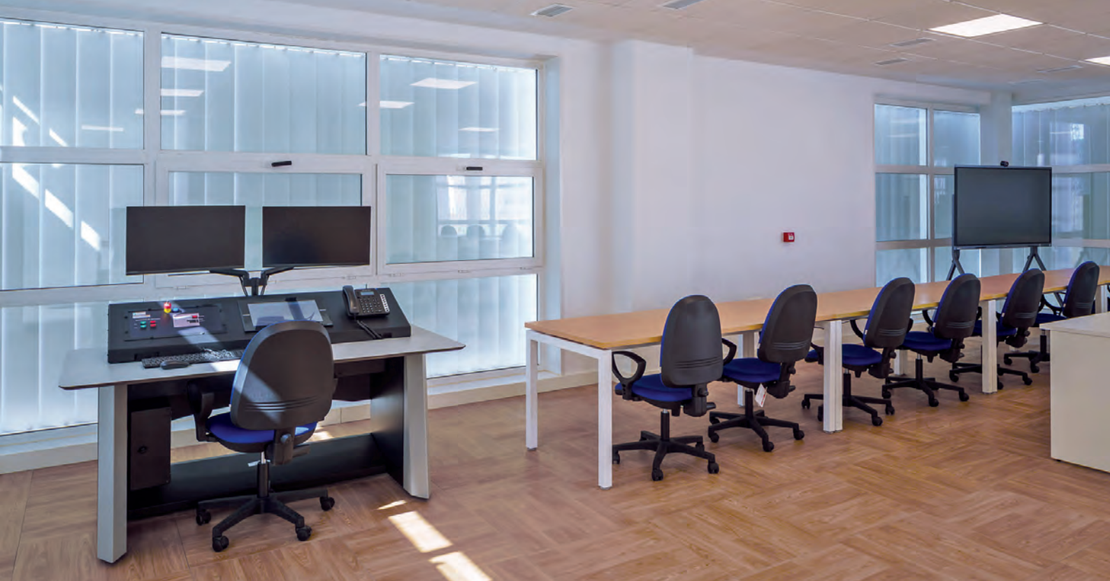
▲ Puesto de control exterior y perimetral
