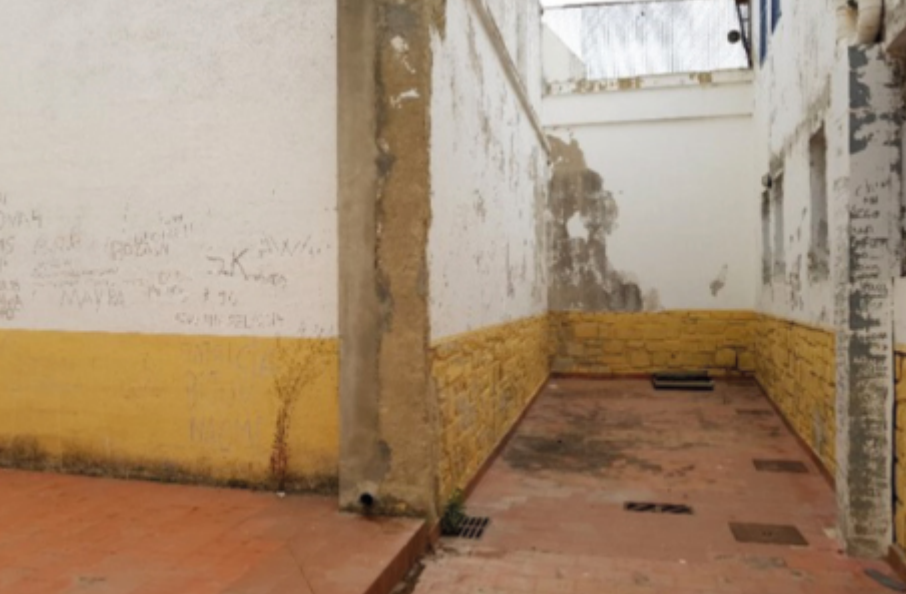
PATIO INTERIOR ANTES DE LA REFORMA
