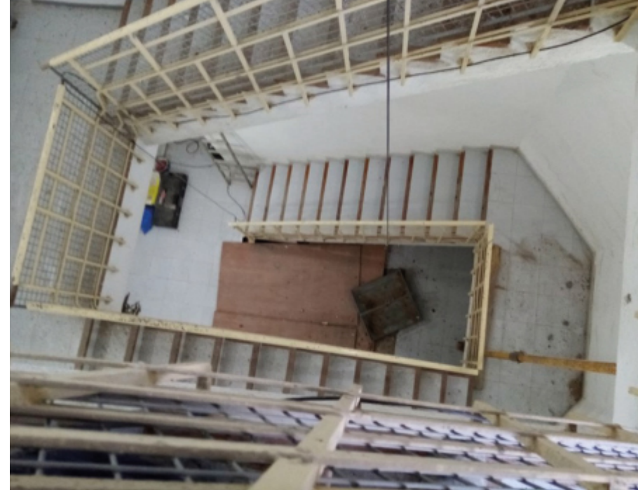
ESCALERAS ANTES DE LA REFORMA
