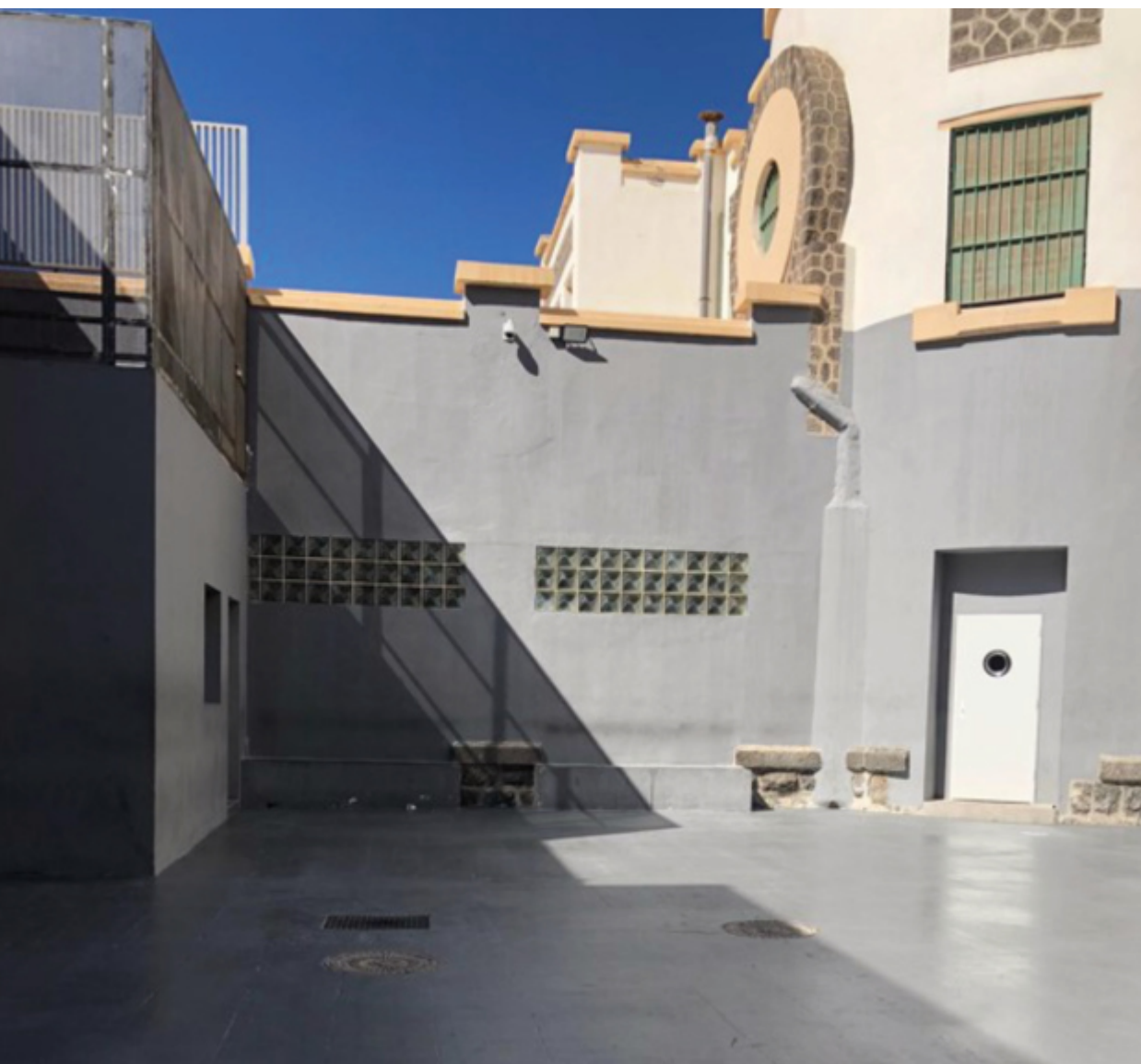
PATIO DESPUÉS DE LA REFORMA. SE PINTA EL SUELO CON PINTURA ANTIDESLIZANTE
