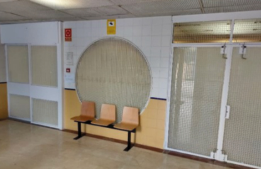
CABINA DE CONTROL ANTES DE LA REFORMA
