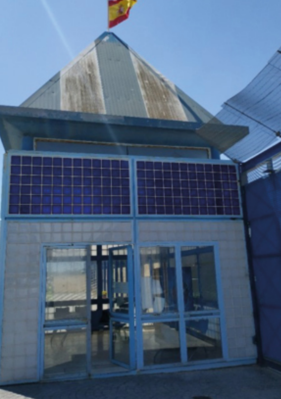
ENTRADA AL CIE ANTES DE LA REFORMA
