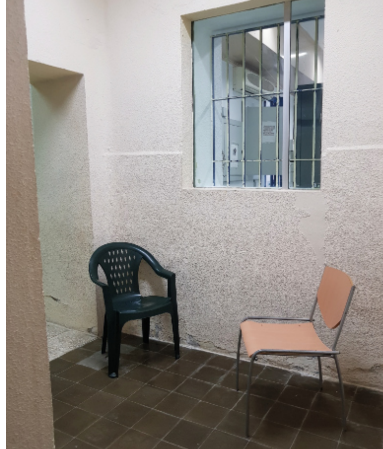
SALA DE COMUNICACIONES ANTES DE LA REFORMA
