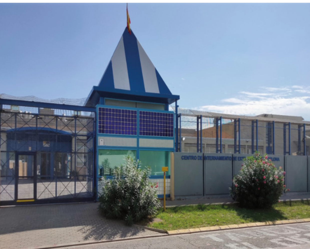
ENTRADA AL CIE DESPUÉS DE LA REFORMA
