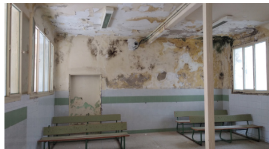
SALA ANTES DE LA REFORMA
