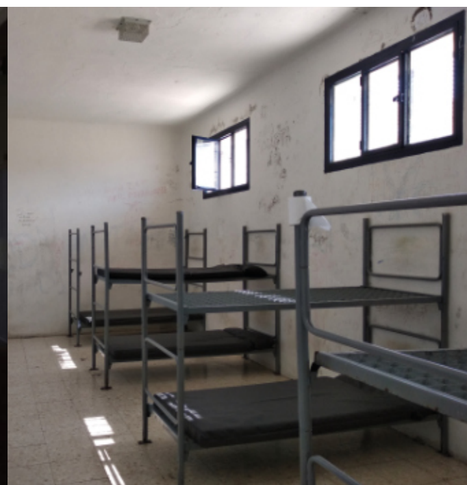
HABITACIÓN ANTES DE LA REFORMA
