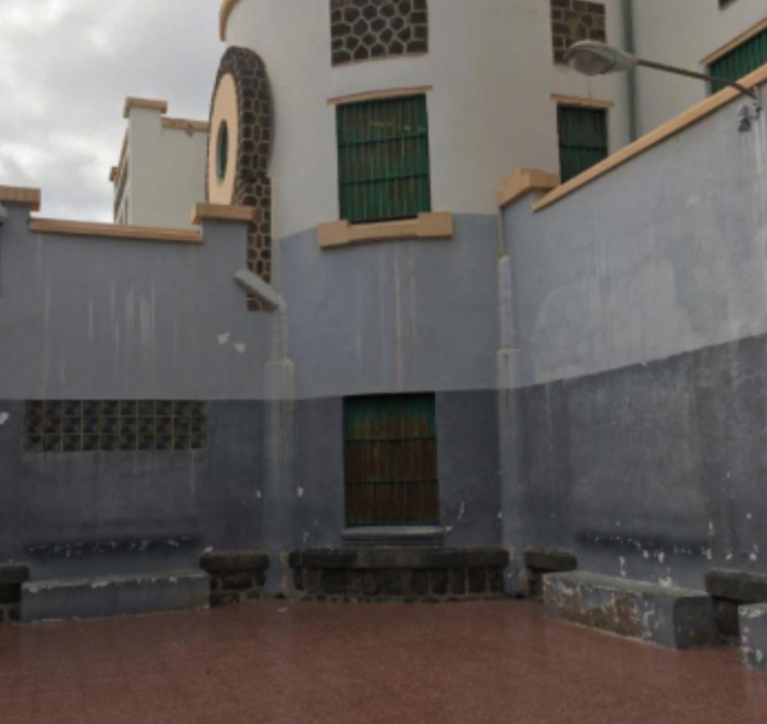
PATIO ANTES DE LA REFORMA
