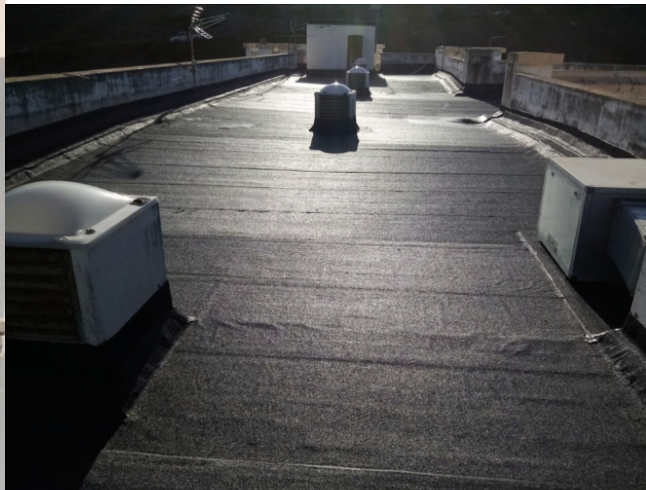
PINTURA E IMPERMEABILIZACIÓN DE LAS CUBIERTAS
