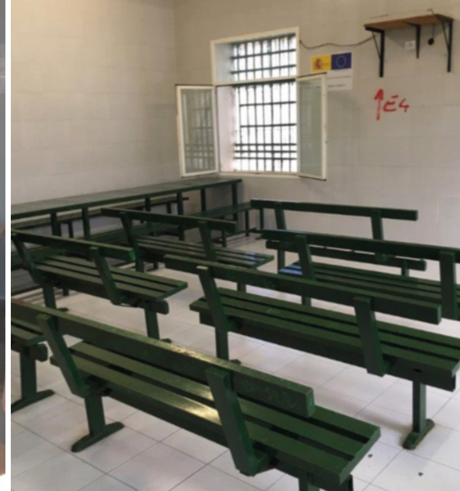
SALA DE ESTAR ANTES DE LA REFORMA
