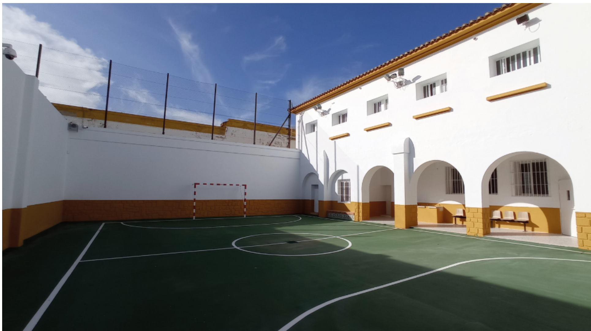
PATIO DE MÓDULO DESPUÉS DE LA REFORMA
