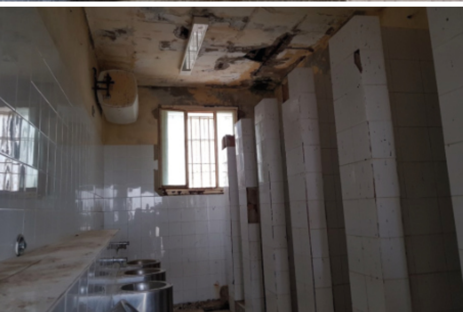
ASEO DE PATIO ANTES DE LA REFORMA
