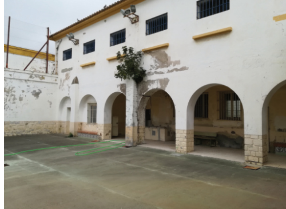
PATIO DE MÓDULO ANTES DE LA REFORMA
